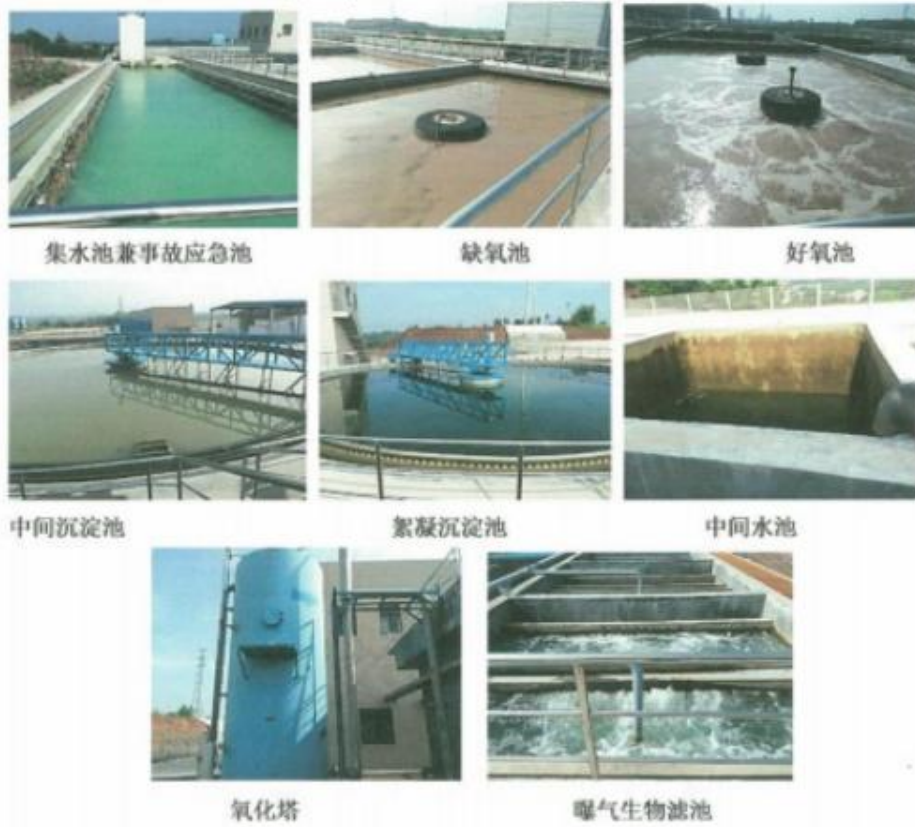
图 2-1, 8000m³/d造纸白水处理站
