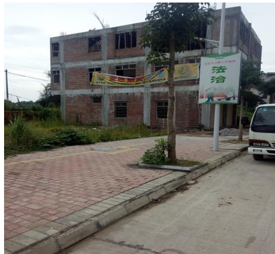
东侧在建民宅
