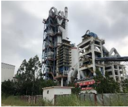
依托的中材罗定水泥有限公司现有新型干法回转窑水泥生产线
